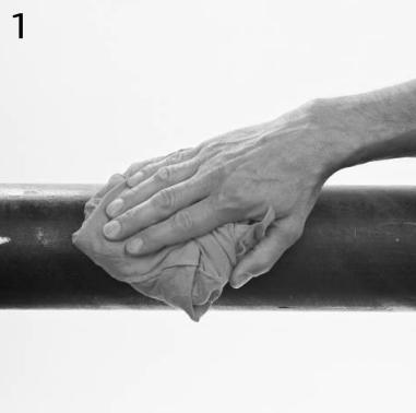
Rohroberfläche reinigen. Keinen Schmutz, lose Anstriche oder Beschichtungen unter der Dichtung.
