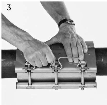
Verschluss einhaken. Schrauben abwechselnd und gleichmäßig anziehen.
