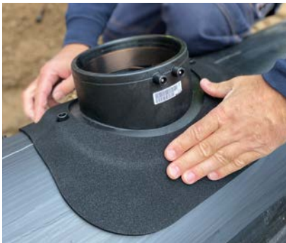
Mit der selbstklebenden Gummimatte wird bei ASA VL d160 der Sattel auf dem Rohr abgedichtet.
