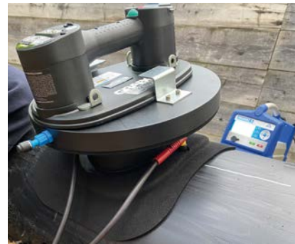
Während des Schweißvorgangs wird das Vakuum gehalten.
